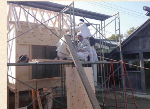
▲神明社の遷宮へ向けて建設中。10月11日に遷宮が行われる。
