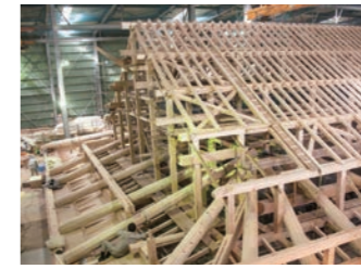
▲上洛殿 素屋根内工事現場
